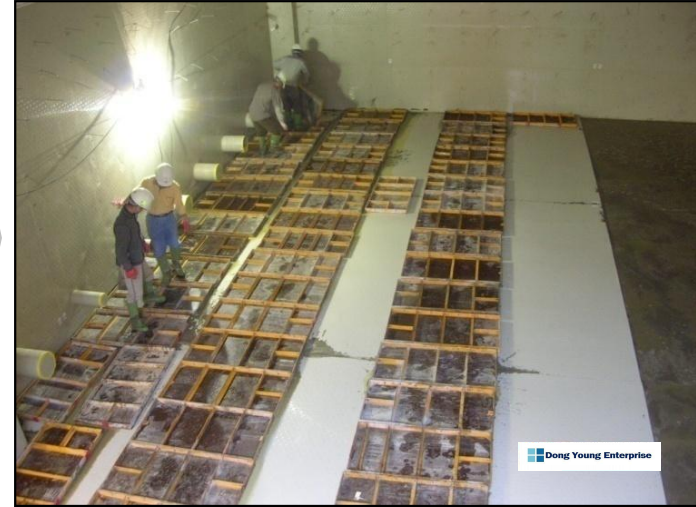
모르타르 타설 및 CPL SHEET 설치
