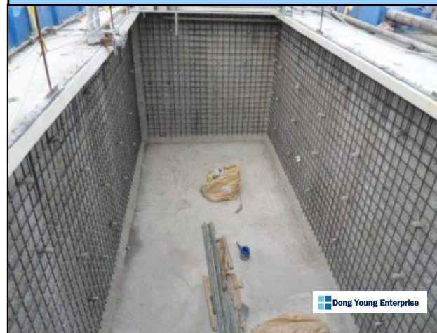
옹벽 철근 작업
